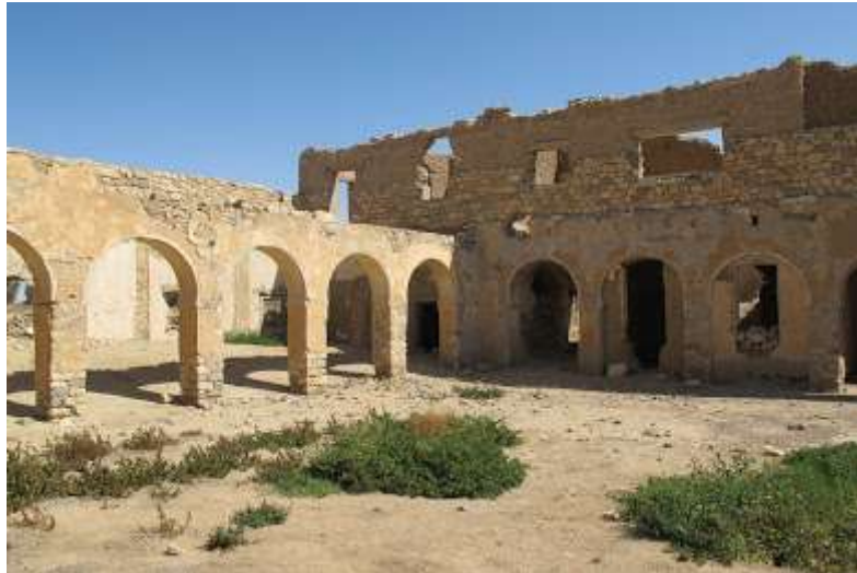
Ancien bâtiment village liana
