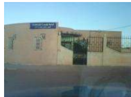
واجهة قاعة متعددة النشاطات تونسي سليمان برأس الجدر
